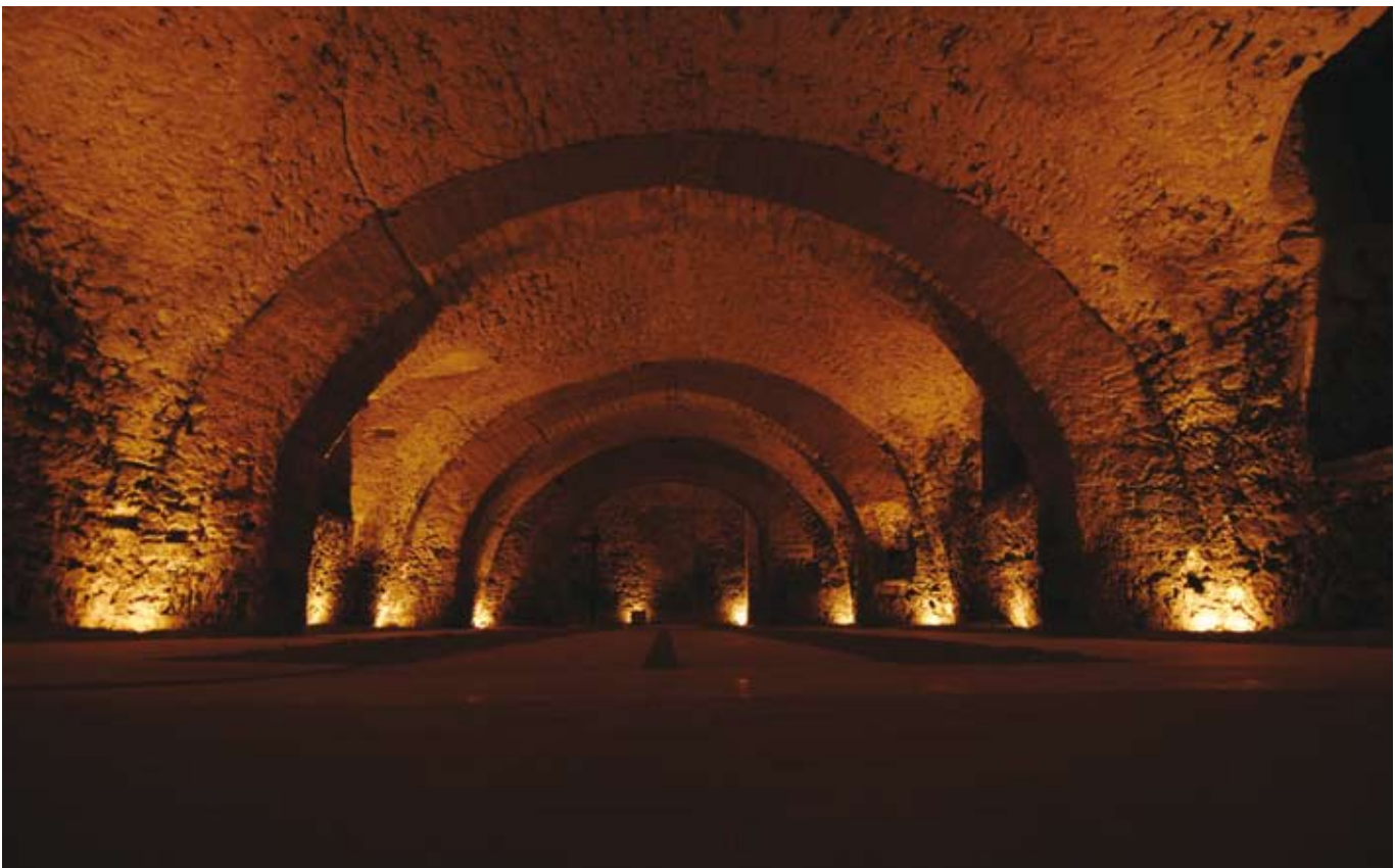
Die beeindruckenden Gewölbekeller von De Fargues, hier in leerem Zustand
